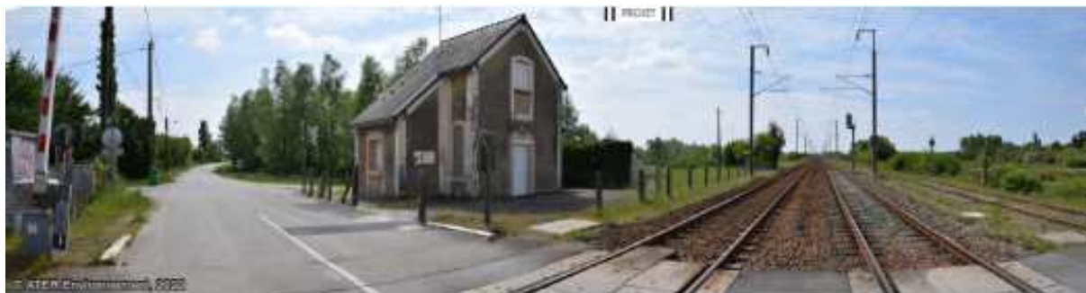
Figure 71 : Vue sur la voie ferrée depuis l'ouest de Camé
