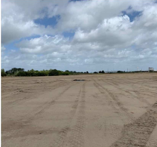
Figure 16 : Photo du site du 27/05/2021
