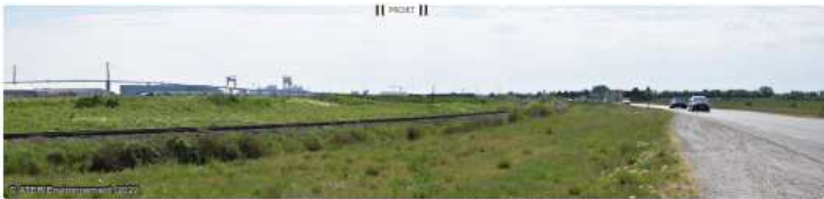
Figure 73 : Vue depuis la D100 qui longe la zone industrialo-portuaire de Montoir-de-Bretagne
