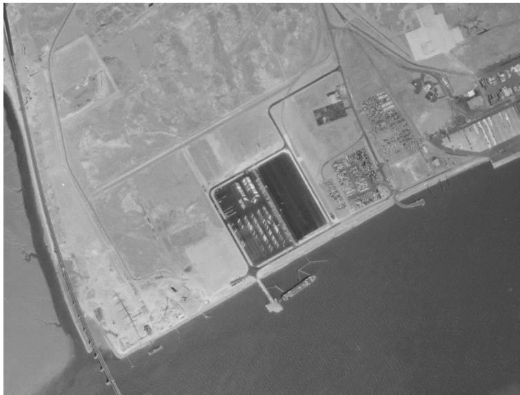
Figure 7 : Vue aérienne de la ZIP de Montoir-de-Bretagne en 1996
