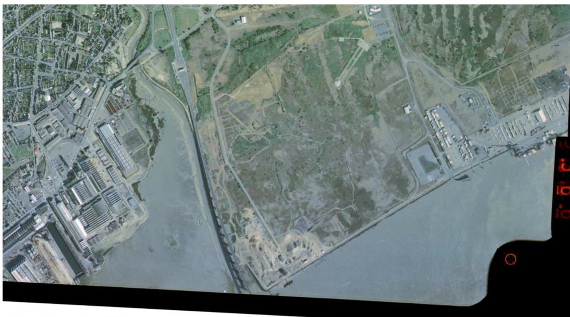
Figure 6 : Vue aérienne de la ZIP de Montoir-de-Bretagne en 1991
