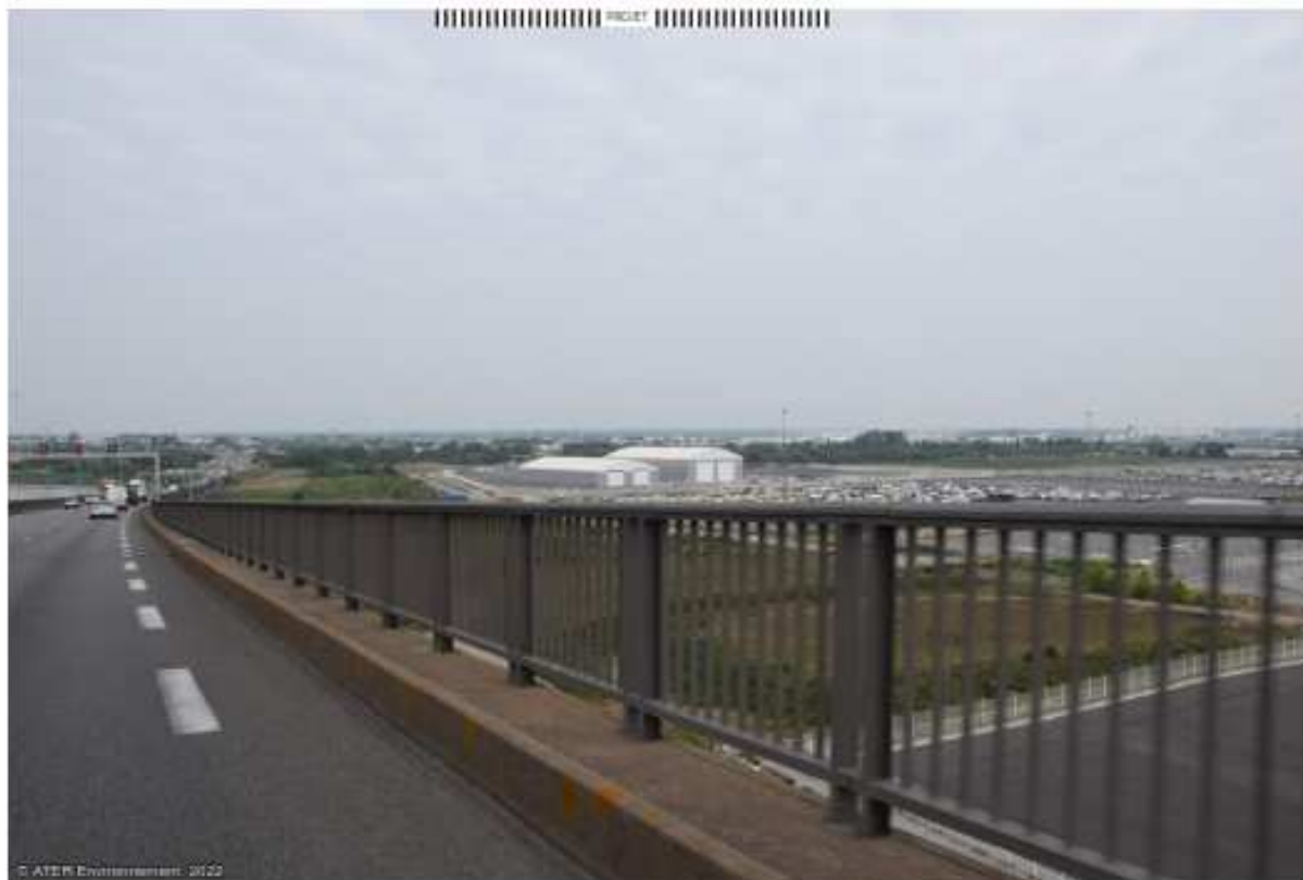
Figure 76 : Depuis la D123 sur le pont de Saint-Nazaire.
