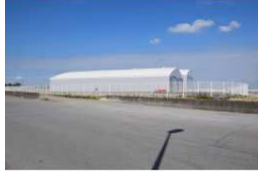
Figure 133 : Bâtiments H7 et H12 déjà construits
