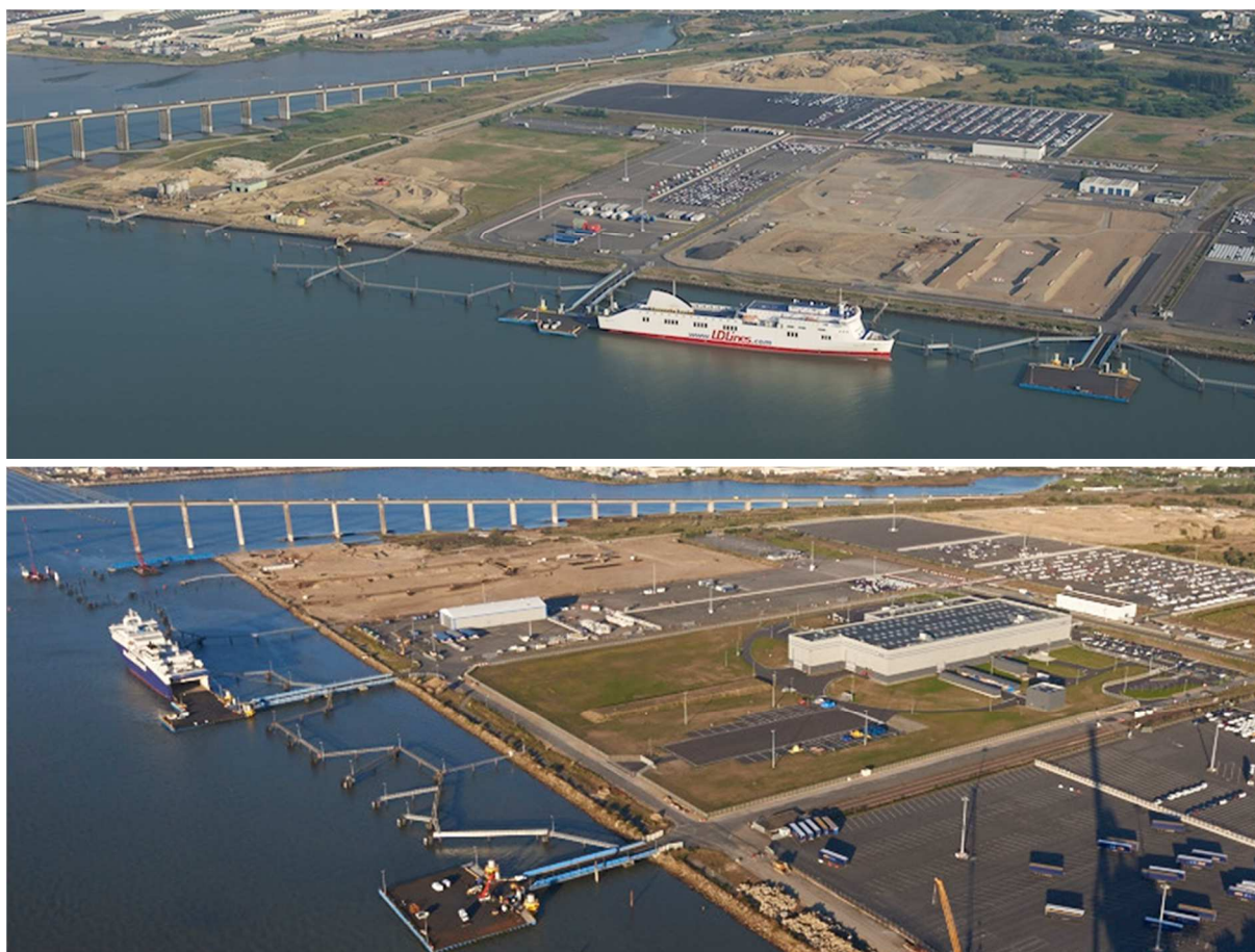
Figure 20 : Plateforme d'accueil de l'usine Alstom (entre les postes rouliers) en cours d'aménagement, en juillet 2013 (en haut), et usine Alstom, en juillet 2015 (en bas)
