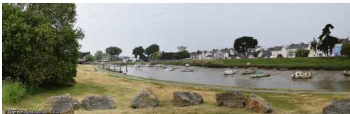
Figure 65 : Vue sur le Brivet à l'aval de l'écluse de Méan
