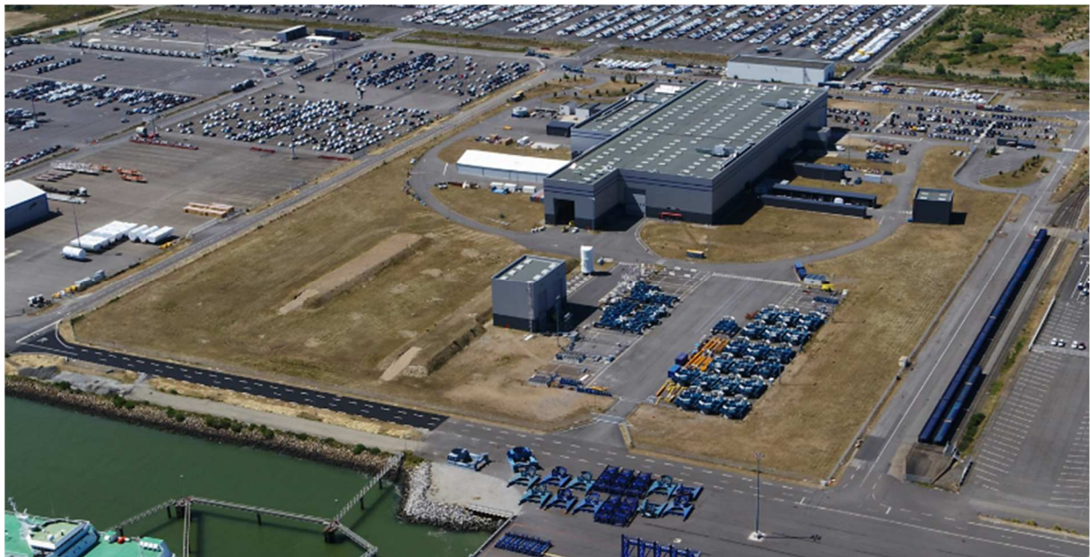
Figure 21 : Usine General Electric, en juillet 2020
